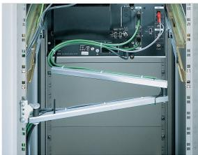
电缆支架臂适合在抽拉式设备和机箱中用作电缆管理工具。利用扎线带将电缆捆扎在一起。
