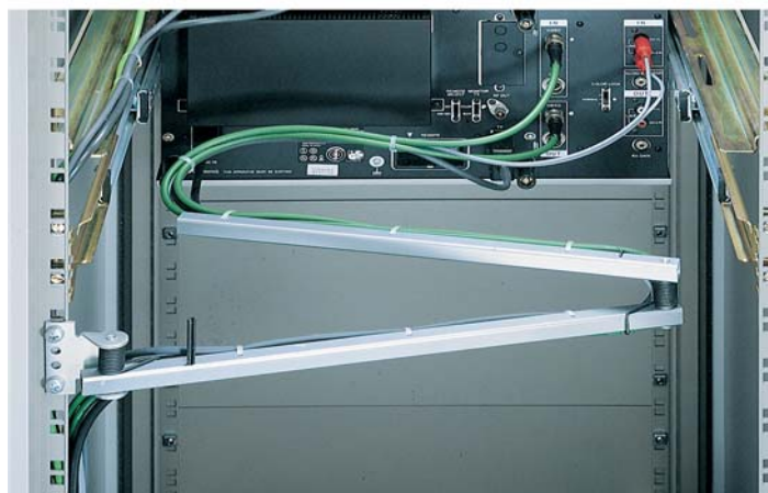
Support de câbles avec ressort de rappel
