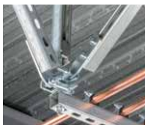
Staffa di Rinforzo per Trapezi, rinforzo con Profilato Strut CSBR2 – p. 28
