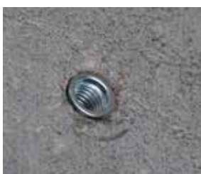
Rinforzo per diramazioni - Connessione per foro filettato CSBBRS3MEG – p. 38
