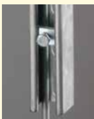
Rinforzo con profilo strut per barra filettata CSBRs37EG – p. 36
