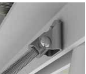
Rinforzo per diramazioni - Connessione per acciaio CSBBS1MEG - p. 37
