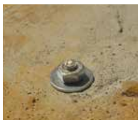
Sistema di ancoraggio ad espansione SABxxxxxx – p. 40
