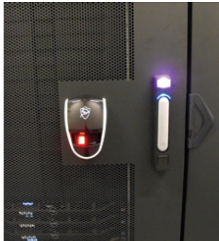
In das SCHROFF-Überwachungssystem integrierter oder mit externen (biometrischen) Zugangskontrollsystemen verbundener elektronischer Griff
