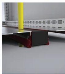
GESTIONE DEL CABLAGGIO
