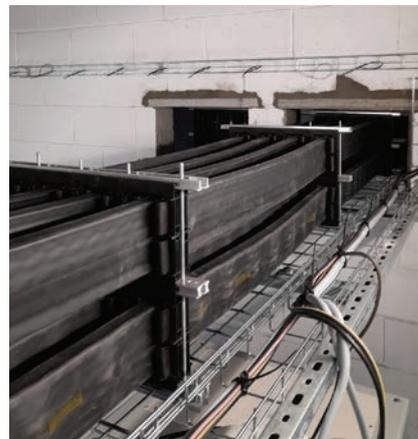
El sistema Flexbus de nVent ERIFLEX es una solución **innovadora** y patentada de conexiones que se ha diseñado para mejorar la eficiencia de las instalaciones de equipos eléctricos, como, por ejemplo, transformadores, cuadros eléctricos, generadores o grandes sistemas de alimentación ininterrumpida (SAI). Su concepto exclusivo ofrece **una instalación hasta un 50 % más rápida** y al menos **un 20 % de reducción del coste total de instalación**.
