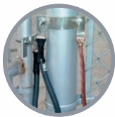
Hek- en poortjumpermontages
