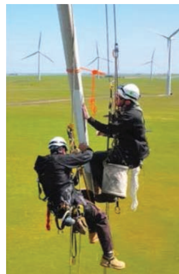
Photo 5 : Réparation des dégâts de la pale
