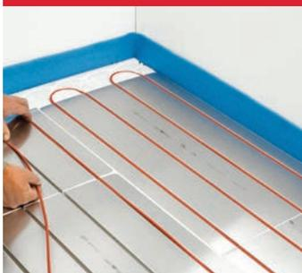
Introduire le ruban chauffant T2Red dans les rainures. La production de chaleur souhaitée est déterminée par l'espacement des boucles du ruban.
