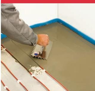
Étendre soigneusement une couche régulière de mortier de remplissage sur le câble. Laisser durcir selon les instructions du fabricant.
