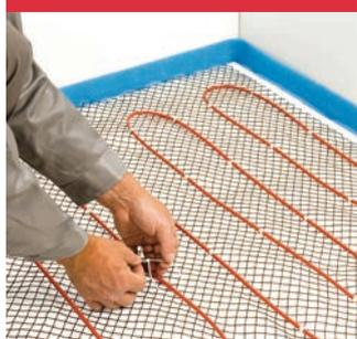
Déterminer l'emplacement des zones à chauffer avant de poser le câble et la chape, en accord avec les plans d'architecte et les consignes du poseur de chape. Fixer le câble sur un treillis métallique (avec des colliers de serrage KBL-10) en respectant les écartements entre les boucles.
