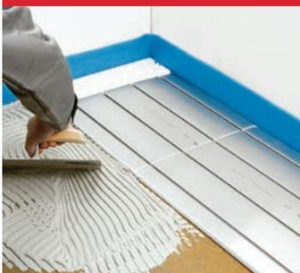
Appliquer la colle Reflecta A-FIX sur le support (dans le cas d'un support en bois, fixer chaque plaque à l'aide de 15 vis). Poser les plaques Reflecta sur la colle.
