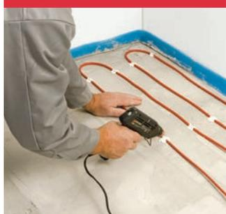
Nettoyer le sol. Appliquer une couche de primer d'adhérence. Fixer le câble (avec un pistolet à colle, par ex.) sur un sol propre.
