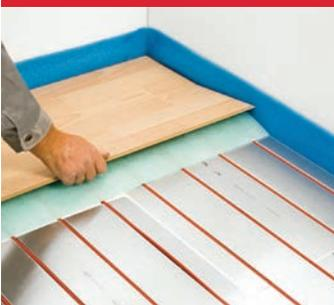
Poser la mousse ou le feutre sur les plaques Reflecta, puis installer le nouveau sol en bois ou en stratifié conformément aux instructions du fabricant.
