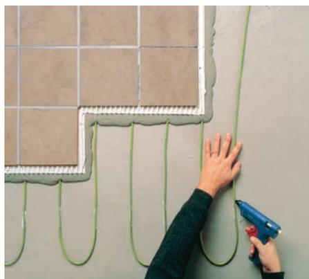
**Le câble flexible pour chauffage par le sol convient pour un usage dans des habitations très bien isolées. Il se pose directement dans un mortier de nivellement.**
