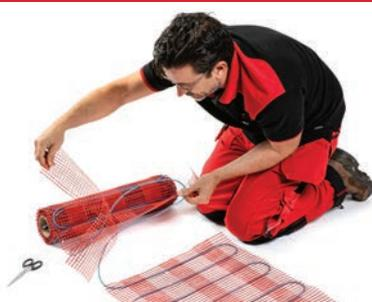
permet également d'installer plus rapidement un système de chauffage par le sol dans les pièces de forme irrégulière.
