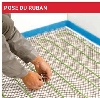
Déterminer l'emplacement des zones à chauffer avant de poser le câble et la chape, en accord avec les plans d'architecte et les consignes du poseur de chape.
