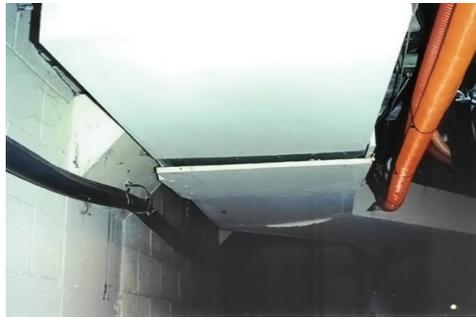
Figure 11. Mauvaise installation d'une enceinte formée de panneaux de gypse
