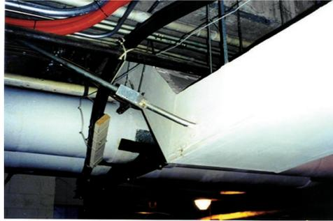
Figure 10. Enceinte de protection des câbles contre la pénétration des câbles inadéquate
