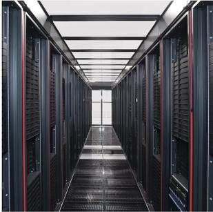
Cubierta superior en diferentes profundidades para configurar un cierre de contención de pasillo.
