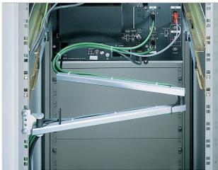
Der Kabelträger ermöglicht es, dass ausziehbare Geräte und Chassis als Kabelmanagement-Tools fungieren können. Die Kabel werden mit Kabelbindern gebündelt.
