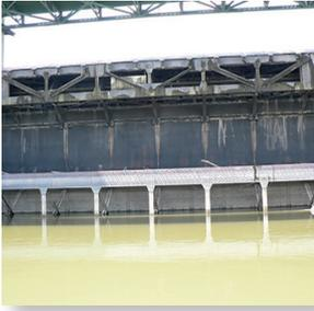
Für die Eisfreihaltung entwickelte Elektro Neumayr mit einer wasserdruckhaltenden Infrarot-Strahlungsheizung mittlerer Wellenlänge die passende Lösung. Dieses System verbraucht verglichen mit seinem Vorgänger nur noch einen Bruchteil der Energie. Es wird ganzjährig durch ein speziell entworfenes Gehäuse vor Schäden und Verschmutzung geschützt und kommt zum Einsatz, wenn die Temperaturen unter den Nullpunkt fallen.
