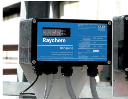
Deshalb müssen die wichtigsten Informationen zur Funktionsfähigkeit der Begleitheizung heutzutage zentral verfügbar sein. Diesen Bedarf erfüllen die Regelungs- und Überwachungssysteme
