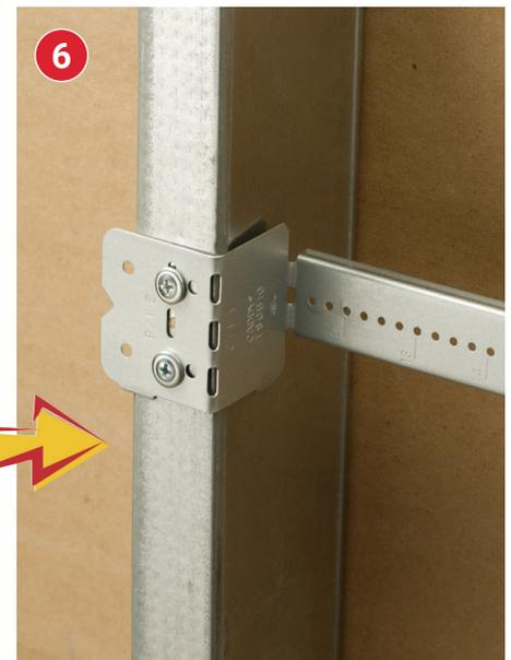
6. Schrauben Sie den TSGB mit Flachkopfblechschrauben (Artikel Nr. 187197) an der Profilstrebe an.
