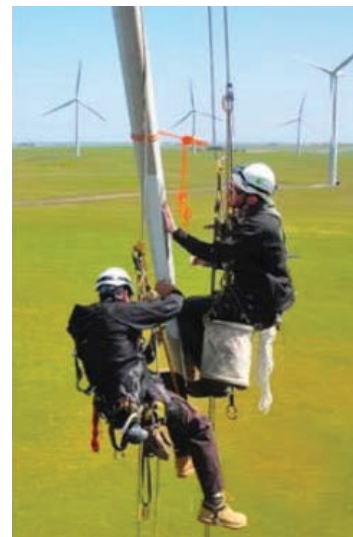
Foto 5: Reparatur von Rotorblattschäden
