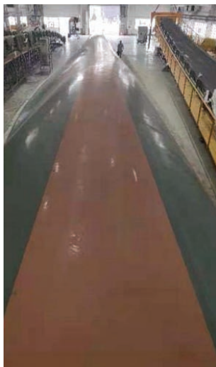
Foto 4: Installation von Kupfergeflecht
