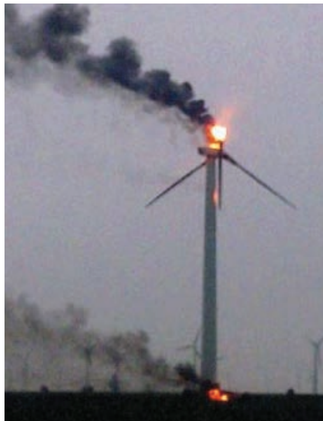
Foto 1: Folgen von Blitzeinschlägen in Windturbinen
